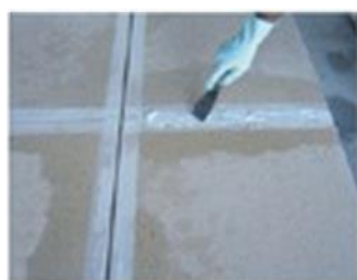
É fundamental a utilização de fita "crepe" aderida nas duas margens das áreas de rejuntamento. Não utilize fitas plásticas adesivas.
