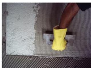
Argamassa na placa com ~ 6 mm, com desempenadeira dentada 8 mm;
