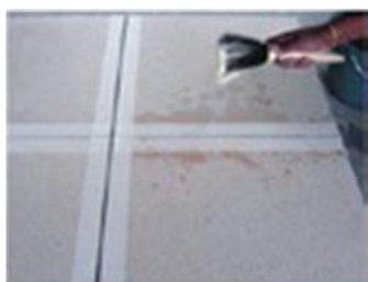
É fundamental a utilização de fita "crepe" aderida nas duas margens das áreas de rejuntamento. Não utilize fitas plásticas adesivas.
