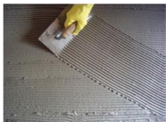
Argamassa no contra-piso 10 mm, com desempenadeira dentada 8 mm;
