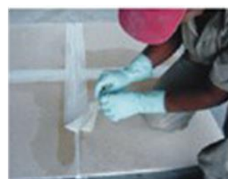
Retirar a fita crepe somente após rejuntamento e início de endurecimento do mesmo. Nunca
